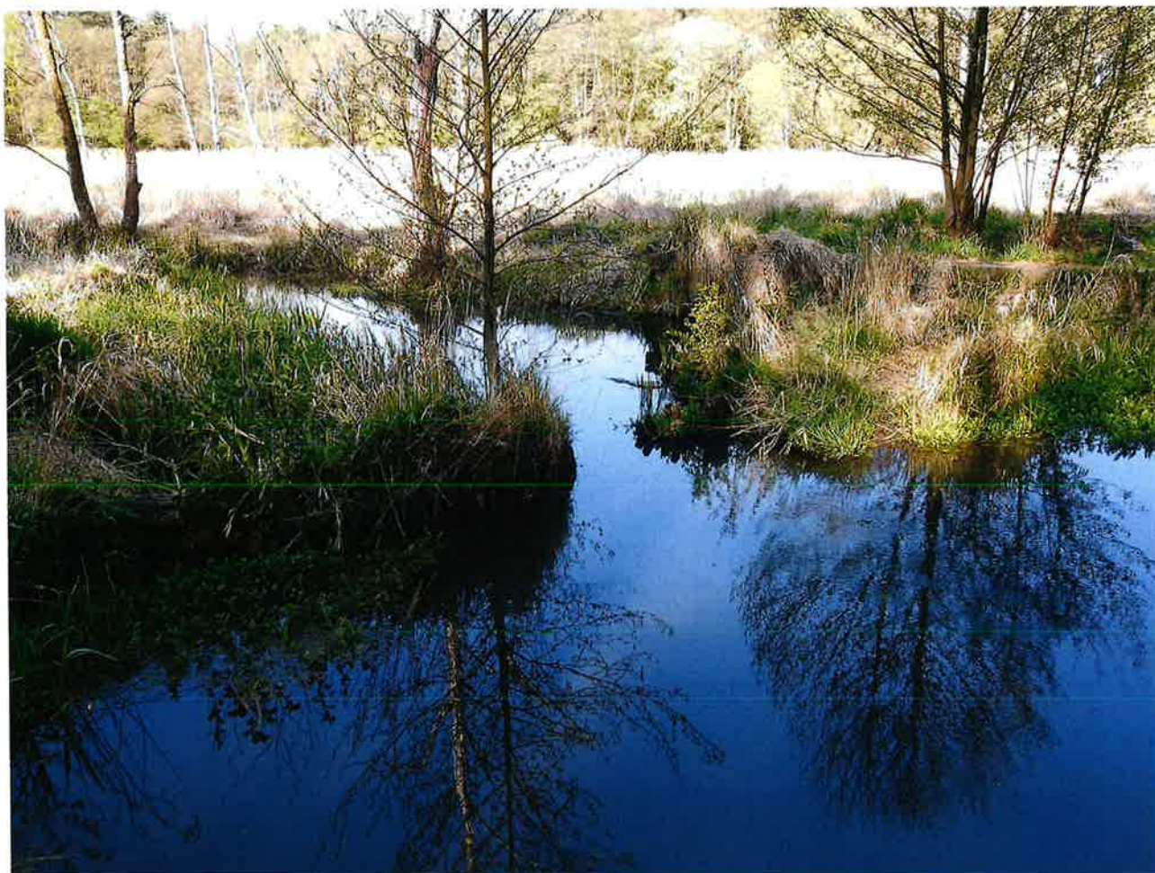
Wlot do Kanału V przy jazu Czarna Widawa w km 3+416 (do przebudowy)
