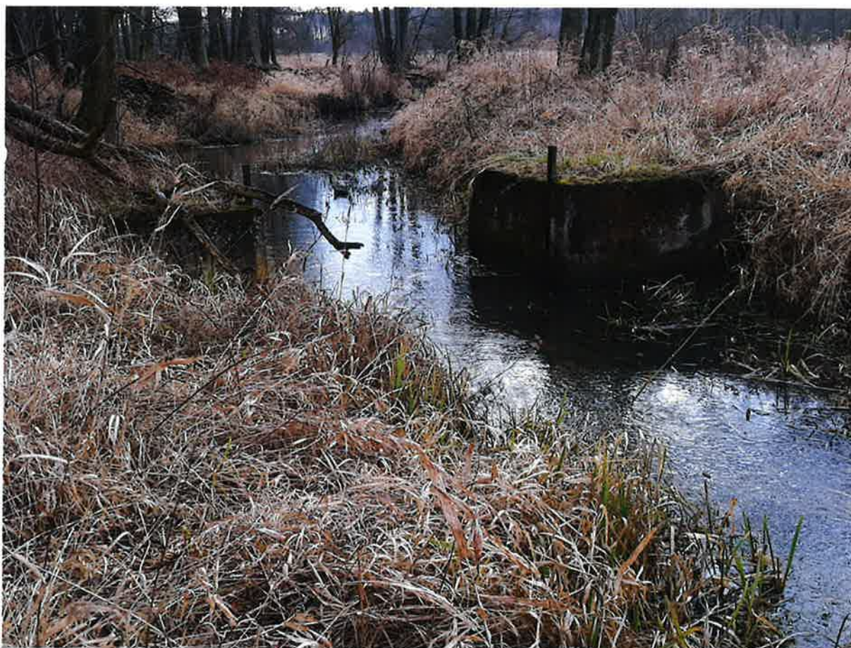
Jaz Czarna Widawa w km 3+416 (do przebudowy)
