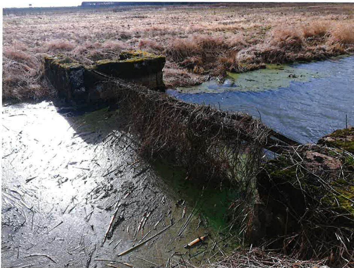
Jaz Czarna Widawa w km 6+750 (do rozbiórki i odbudowy)
